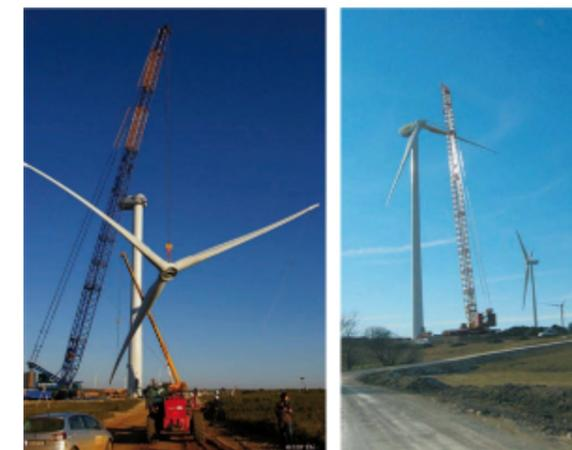
Photographie 6 : Montage du rotor (à gauche), montage « pale par pale » (à droite)
