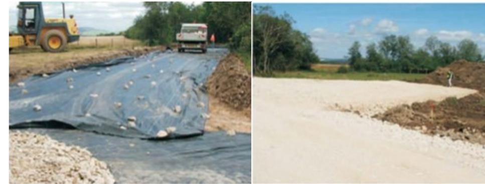
Photographie 5 : Pose d'un géotextile (à gauche), état final d'une plate-forme (à droite)
