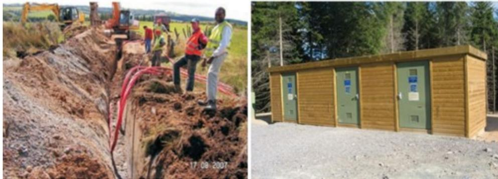
Photographie 7 : Déroulage et pose des câbles (à gauche), poste de livraison (à droite)
